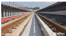
轨道与路基工程
